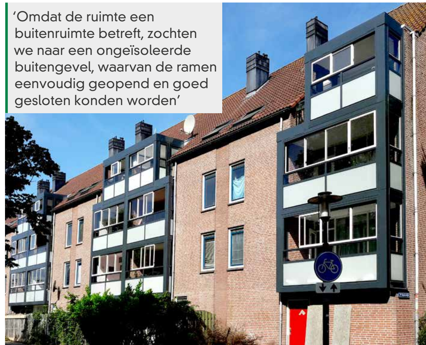
Appartementen Wolfstraat ná de renovatie.
