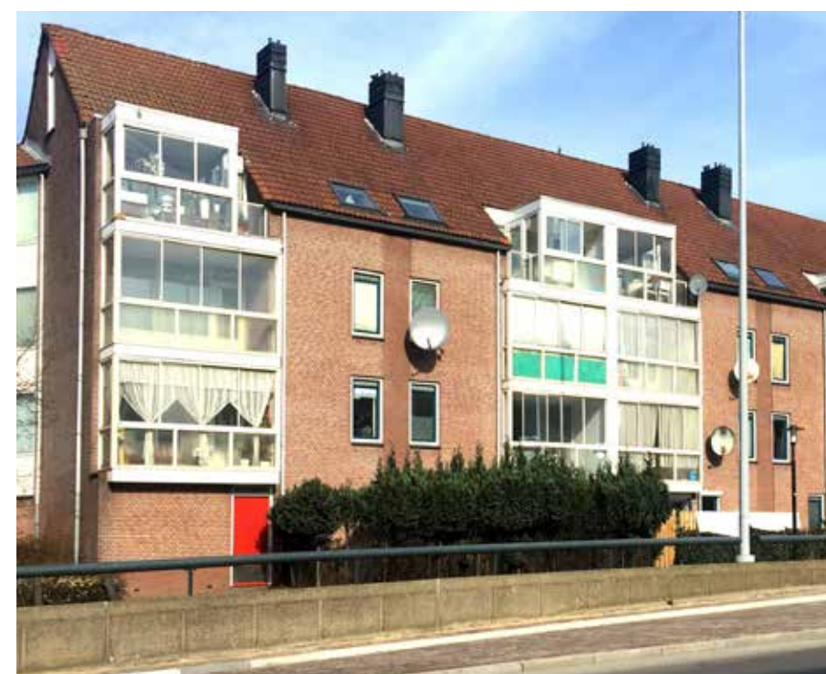
Appartementen Wolfstraat vóór de renovatie.
